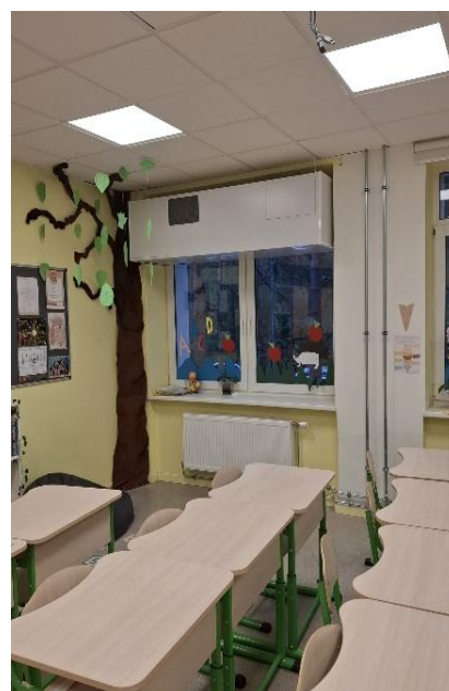
2.attēls. MESH gaisa ventilācijas sistēma
